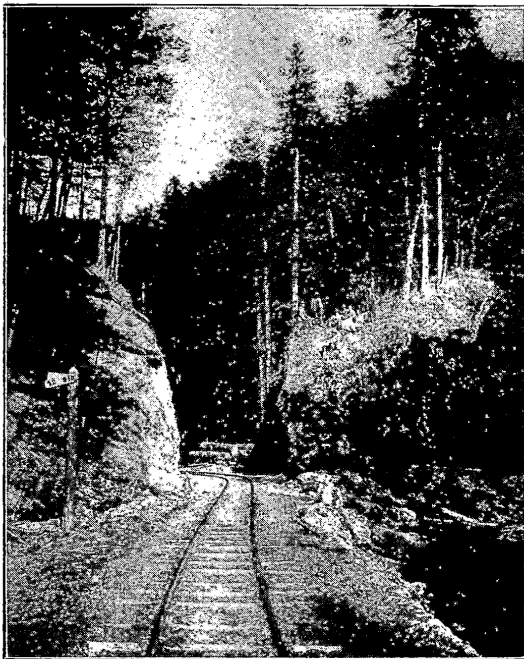
Сл. 18. Привремено заштитна шума у Босни. Шума чува железницу од засипања пруге камењем, земљом и снегом.
